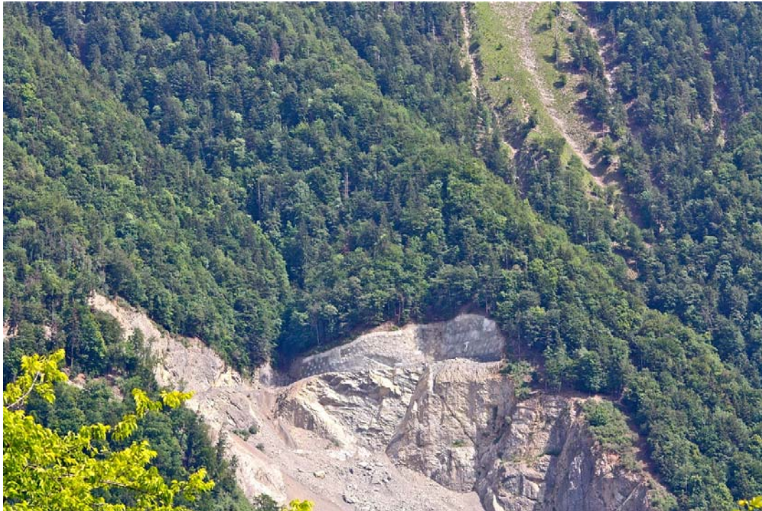
Figure 2: sommet de la carrière du Châble-du-Midi.
